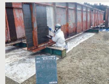
蛇尾川防災ステーションにて既済桁の塗装剥離作業
