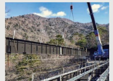
550tトラッククレーンにて新規製作桁の架設
