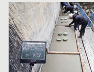
既設橋台の沓座改築工におけるコンクリート打設後の仕上げ作業
