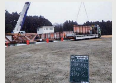
既設桁を切断し、蛇尾川防災ステーションに運搬
