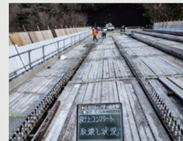
床版コンクリート撤去後、主桁上フランジ上コンクリートのはつり作業実施
