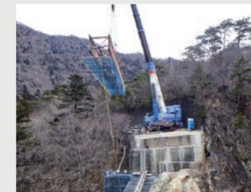
550tトラッククレーンにて既設桁を撤去
